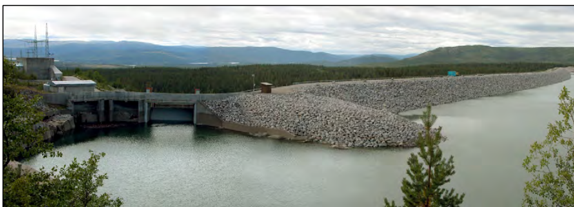
Figur 13. Demningen ved Seitevare kraftverk. Bildet er tatt i retning sørvest hvor ny 420 kV ledning vil komme fra. Foto: Martin Andersson. 2
