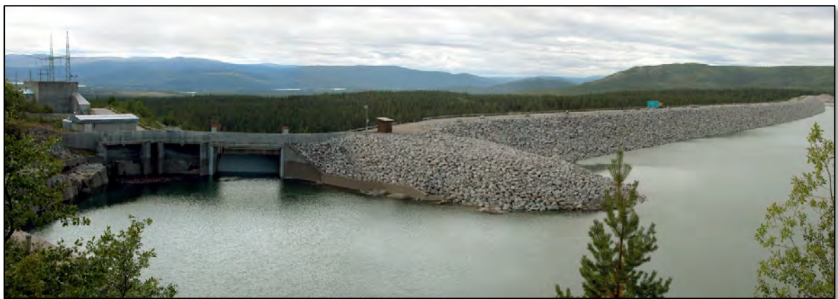
Figur 15. Demningen ved Seitevare kraftverk. Bildet er tatt i retning sørvest hvor ny 420 kV ledning vil komme fra. Foto: Martin Andersson. 2
