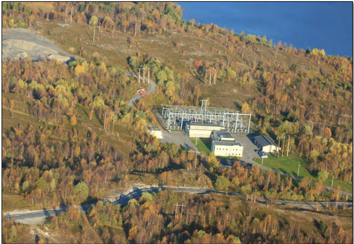
Figur 9. Eksisterende trafo og koblingsanlegg ved Fagerli.
