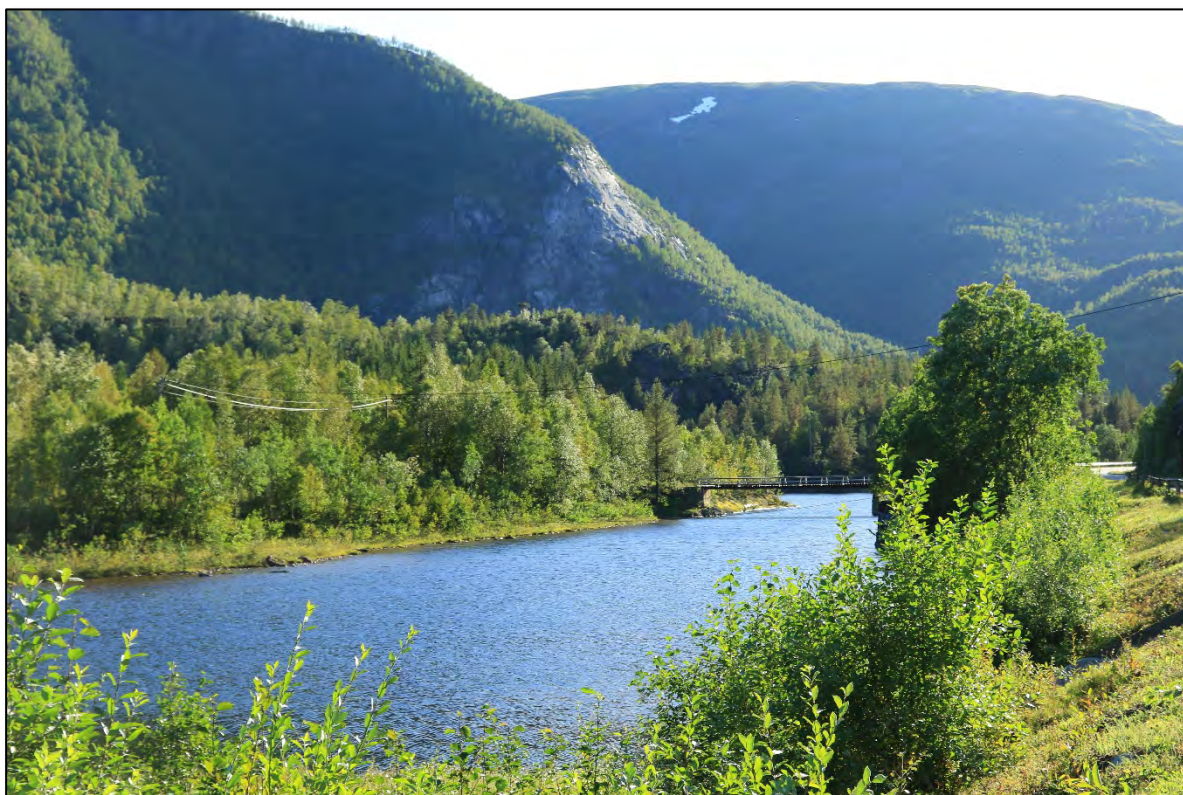
Figur 16. Nettilknytning mot Salten trafo innebærer ny 420 kV ledning langs Sulitjelmavassdraget fra de åpne områdene langs Langvatnet (øverst) og ned det trange dalføret langs Sjønståelva.
